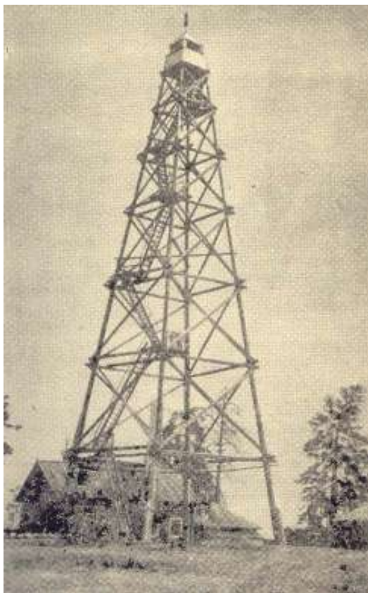
Рис. 74. Пожарная наблюдательная вышка
