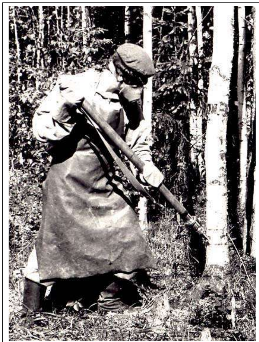
Рис. 72. Уход за елью с применением инъектора ИП-4
