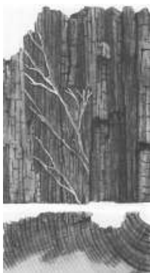
Наружная трухлявая гниль (сосна)
