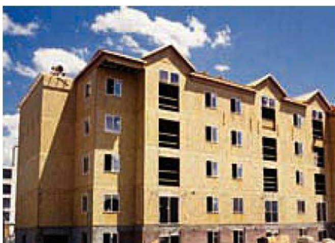
Рисунок 16 – Применение плит OSB в строительстве
