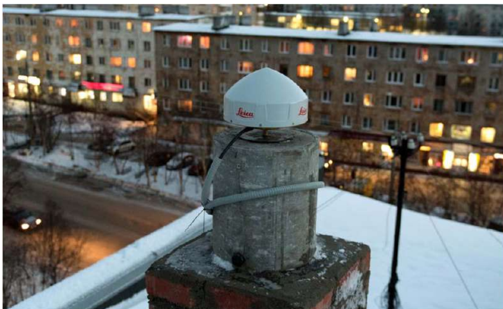
Рис. 5 Вид рабочего центра пункта ФАГС
