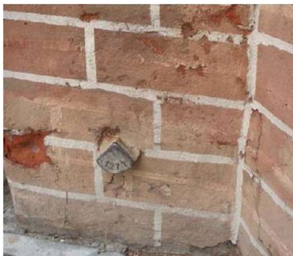
Рис. 12. Стенной репер
