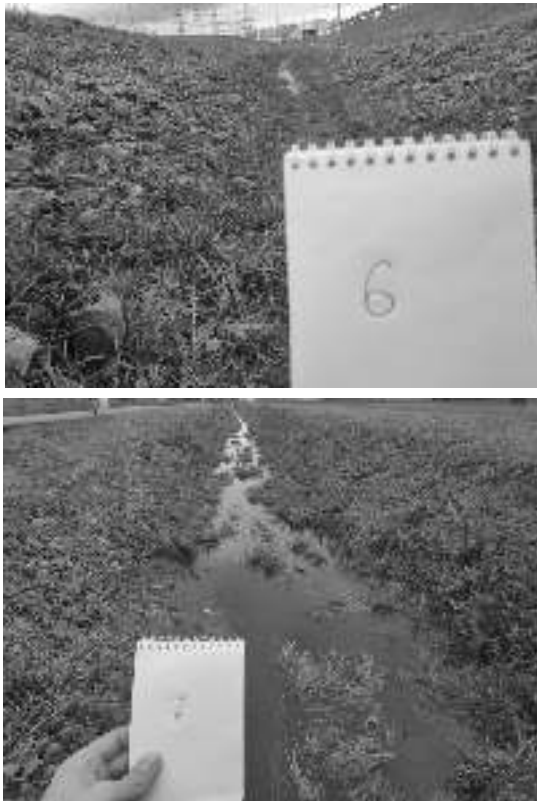
Рис 4. Продольный водоотвод дороги общего пользования 2-й категории в г. Санкт-Петербург
