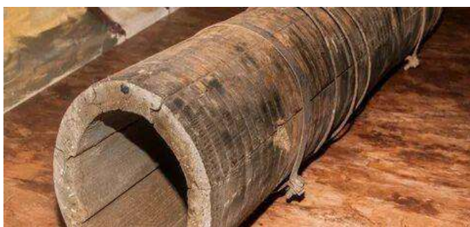
Рис. 5. Соединения клепок деревянных труб
